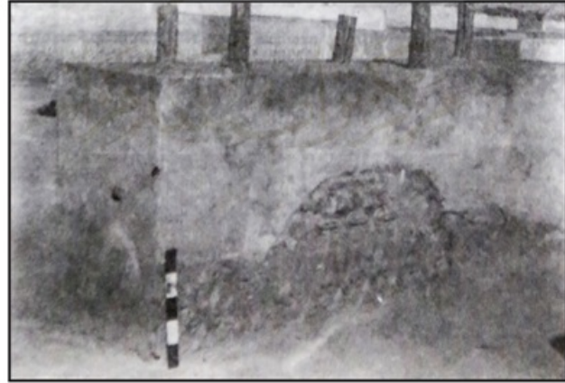
لوحة ٣٩ يوضح استخدام الخشب (القوغ) بصورة عمودية داخل الجدران من الجهتين وتمتد ارتفاع الجدار (بعد الصيانة).
