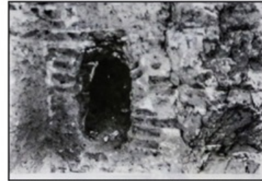
(لوحة ١٩) يوضح اللبن الطيني الذي استخدم لملئ الفراغات لاستغلالها ككوي للغرفتين ١٧ و ١٩.
