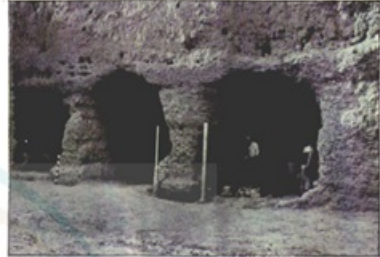
مطلة هاربة الساع القسم الشرقي قبل الصيانة وبعد رفع الأتربة وأعمال التنظيف عام ١٩٨٢
