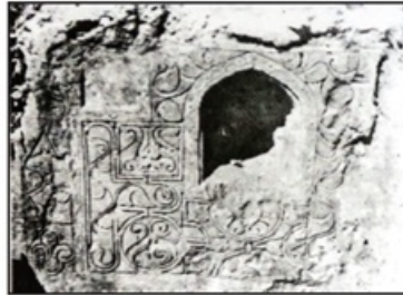
(لوحة ٩ ب) يوضح الطاقة الصماء (الكوي) ذات القوس المدبب المرسوم من أربع مراكز. الصورة مسحوبة سنة ١٩٣٦.
