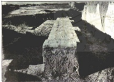
غايا الجدران الكنتشة في الجهة الجنوبية من القل الكبر الخدي لملقة هاربة الساع قبل الصيانة وبعد الصيانة عام ١٩٨٢
