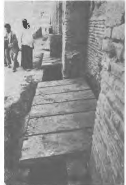
خسارات وارده توسط نفوذ نم و رطوبت و پیشگیری از آن. ۱۶۷ - ۱۶۹. عملیات در پوشش شبستان (همان شماره ۳۱۰). ۱۷۰. پوشش کسابل اهدائی در کنار دیوار خارجی شبستان برای جلوگیری از نفوذ رطوبت و هواکشی آن (ضلع غربی).
