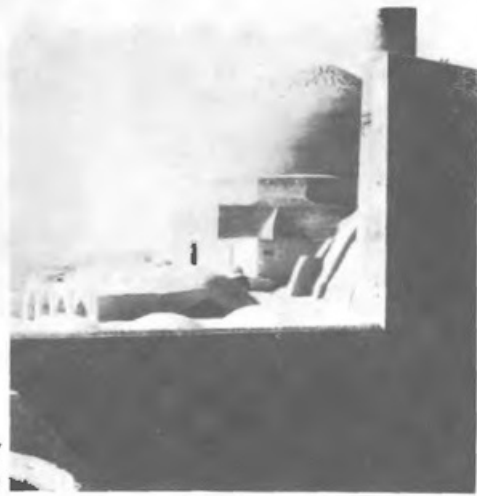
کلبه جنوبی: ۲۹ - ۳۰. گوشه شمال شرقی قبل و بعد از عملیات مرمتی.
