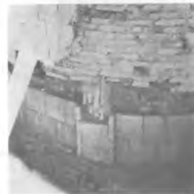
طاق و چشمهها: ۱۴۵. سطح خارجی طاق و چشمه نهانه شماره ۶۰، ۱۴۶. جزئیات ساختمانی طاق‌بندهای همان نهانه که در آن لایه دونه مشاهده می‌شود. ۱۴۷. جزئیات داخلی بعد از تعمیرات. ۱۴۸ - ۱۴۹. طاق و چشمه شماره ۶۳ منظره داخلی و خارجی که وضعیت فعلی مشاهده می‌شود.
