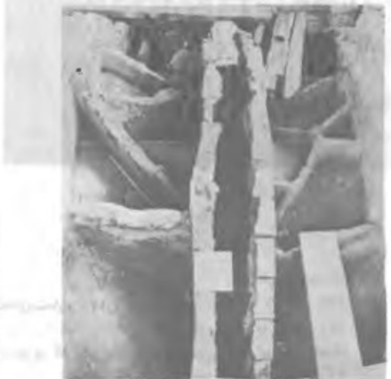
راهروی جانبی ایوان شرقی: ۱۱۳. شکستگی اصلی در دیوار جنوبی (دهانه شماره ۱۰۲). ۱۱۴. بقایای یک پوشش طاق و چشمه‌ای بر روی دیوار خارجی (دهانه شماره ۱۰۲). ۱۱۵. طاق‌نماهای مقرنس‌مانند در دهانه شماره ۱۰۲ قبل از اقدامات I.S.A. ۱۱۶ و ۱۱۷. سازهای بازیر طاق‌بندی‌ها در حین عملیات استحکام‌بخشی توجه شود به نشانه طاق‌های پرچسبان توخالی.
