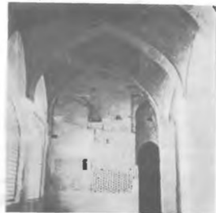
ایوان جنوبی: ۴۹ و ۵۰. نمای ایوان جنوبی در خلال سال ۱۹۴۸ (عکس از ا. گسدار) و سال ۱۹۷۴ عملیات مرمت. ۵۱-۵۲. جبهه شرقی و غربی ایوان جنوبی در حین عملیات مرمتی.
