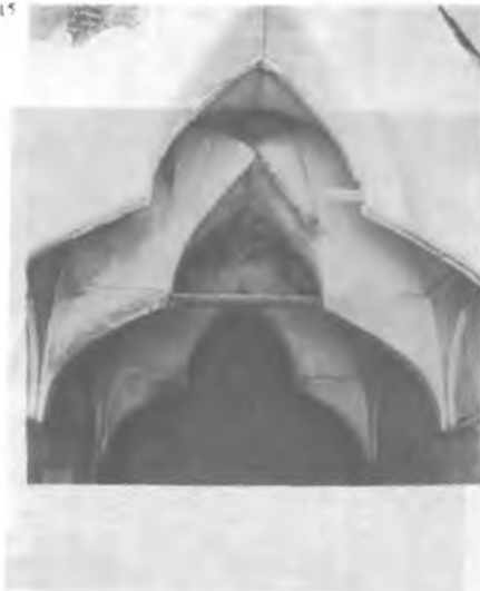
راهروی جانبی ایوان شرقی: ۱۱۳. شکستگی اصلی در دیوار جنوبی (دهانه شماره ۱۰۲). ۱۱۴. بقایای یک پوشش طاق و چشمه‌ای بر روی دیوار خارجی (دهانه شماره ۱۰۲). ۱۱۵. طاق‌نماهای مقرنس‌مانند در دهانه شماره ۱۰۲ قبل از اقدامات I.S.A. ۱۱۶ و ۱۱۷. سازهای بازیر طاق‌بندی‌ها در حین عملیات استحکام‌بخشی توجه شود به نشانه طاق‌های پرچسبان توخالی.
