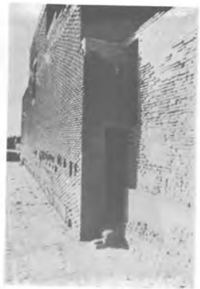
۳۳ - ۳۴. گوشه جنوب غربی قبل و بعد از عملیات مرمتی.
