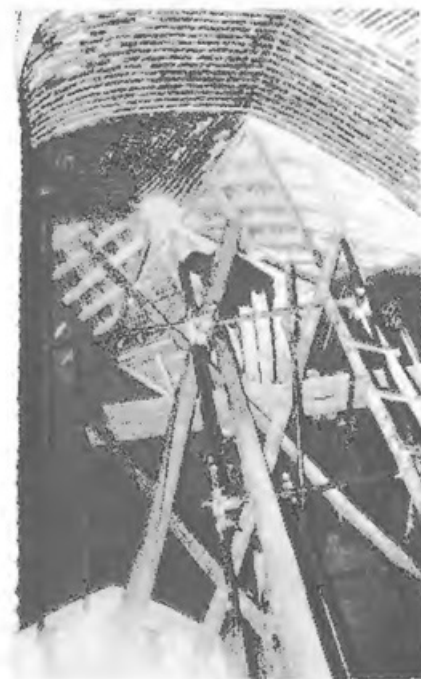
طاق و چشمه‌ها: ۱۵۵ - ۱۵۶. سطح خارجی طاق‌بندهای دهانه‌های شماره ۷۲۵ و ۱۵۳. ۱۵۷ - ۱۵۸. دهانه شماره ۴۱۳ در حین عملیات استحکام‌بخشی پوشش طاق و چشمه آن.
