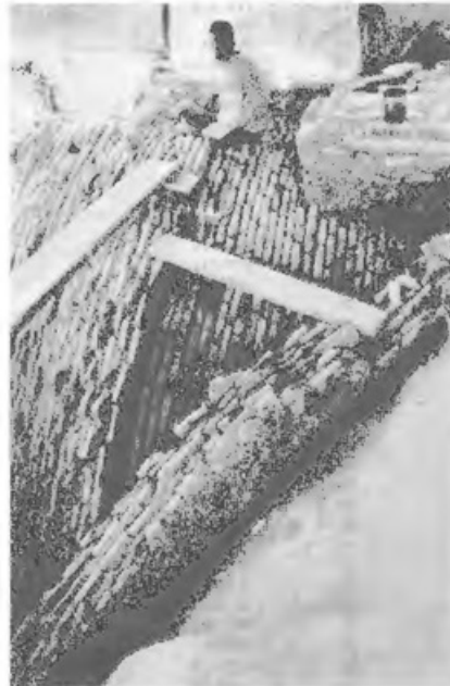
خسارات وارده توسط نفوذ نم و رطوبت و پیشگیری از آن. ۱۶۷ - ۱۶۹. عملیات در پوشش شبستان (همان شماره ۳۱۰). ۱۷۰. پوشش کسابل اهدائی در کنار دیوار خارجی شبستان برای جلوگیری از نفوذ رطوبت و هواکشی آن (ضلع غربی).
