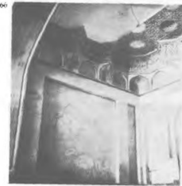
ایوان شمالی: ۶۵. قطعاتی از تزئینات کچی قدیمی در گوشه شمال غربی، ۶۶ - ۶۷. دو دهانه مسدود شده در طرفین قسمت شاهنشین، ۶۸. ستون ملور و استوانه‌های شکل قدیمی که در درون دیوار مخفی شده است.
