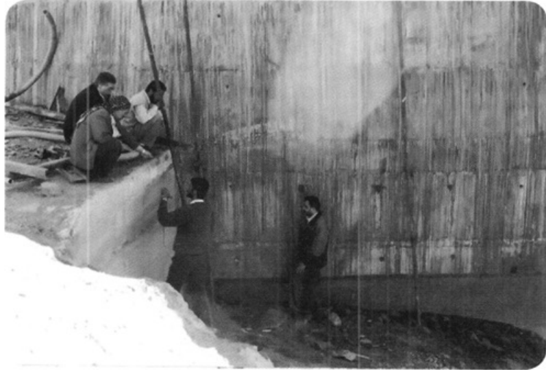
دیواره سد خمینی شهر
