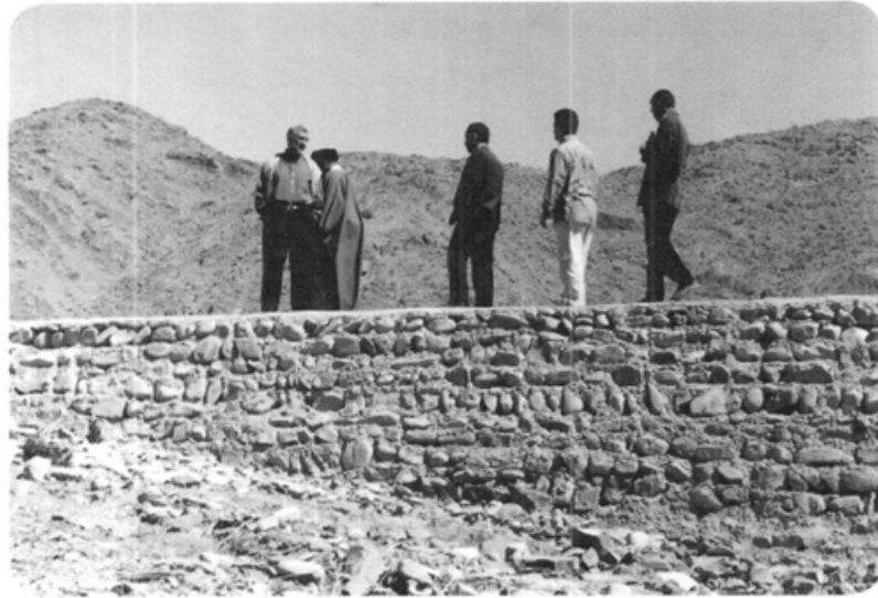
نمونه ای از بندهایی که در طرح آبخیزداری احداث شده
