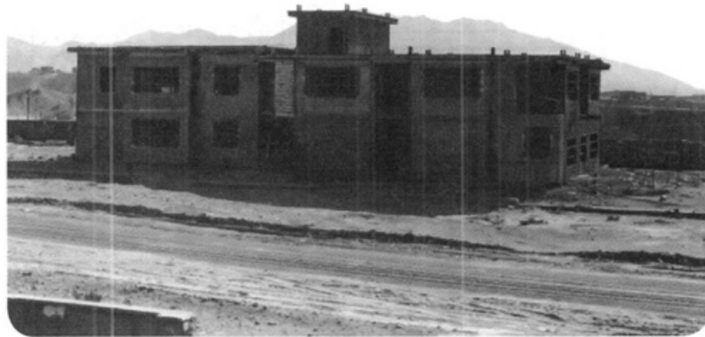
خوابگاه دانش آموزان در حال احداث
