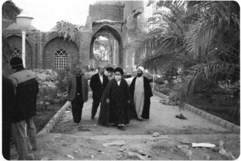
منطقه زلزله زده بم
