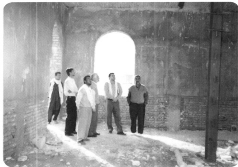
مسجد در حال احداث خمینی شهر
