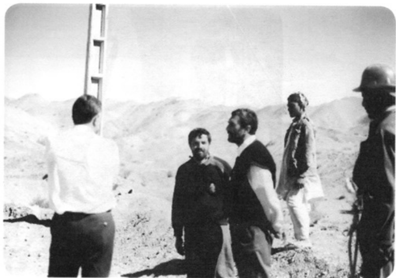
نصب اولین پایه بتونی برق در بشاگرد
