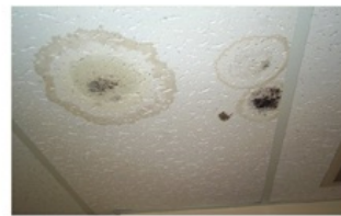
تصویر شماره ۲۷: تجمع اسپور و کلنی قارچی متعاقب نشت آب در سقف
