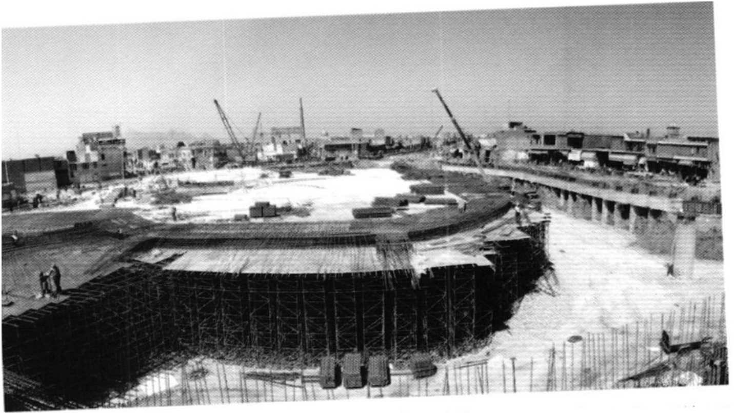
تصویر 118: عملیات اجرای سقف بتنی فلکه سواره احداث شده در تراز زیر زمین، سال 1388 - مأخذ: مرکز اسناد سازمان نوسازی و بهسازی شهر اصفهان
