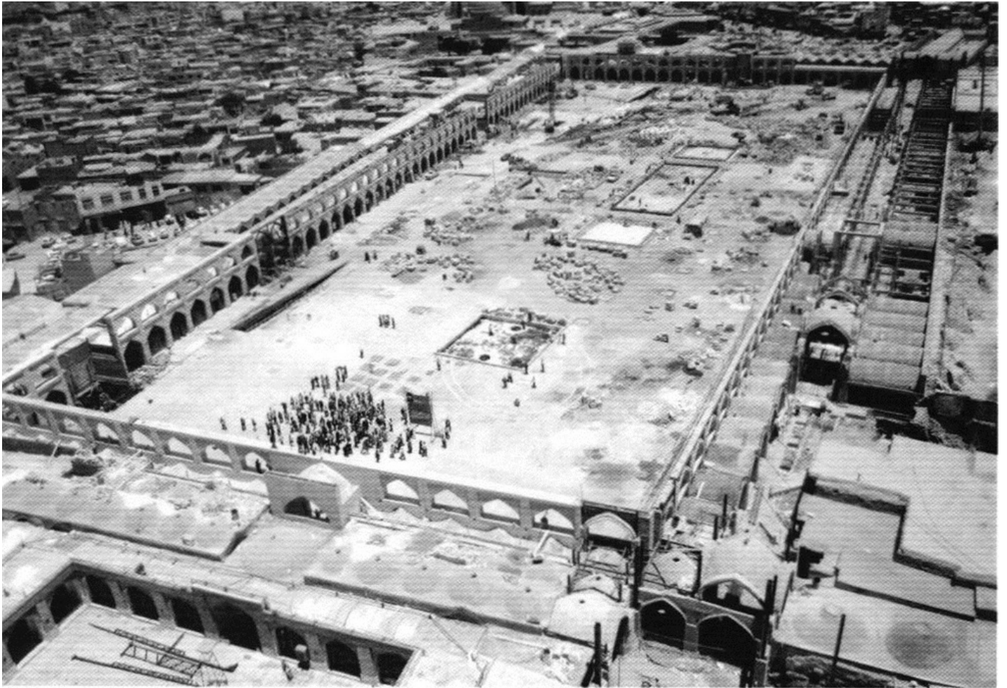
تصویر 132: میدان امام علی (ع) در فرایند اجرای فاز دوم (یازدهم تیر ماه 1392) - مأخذ: مرکز اسناد سازمان نوسازی و بهسازی شهر اصفهان
