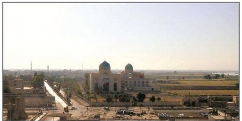
نمای زیارتگاه عمار یاسر پس از تخریب مناره آن
