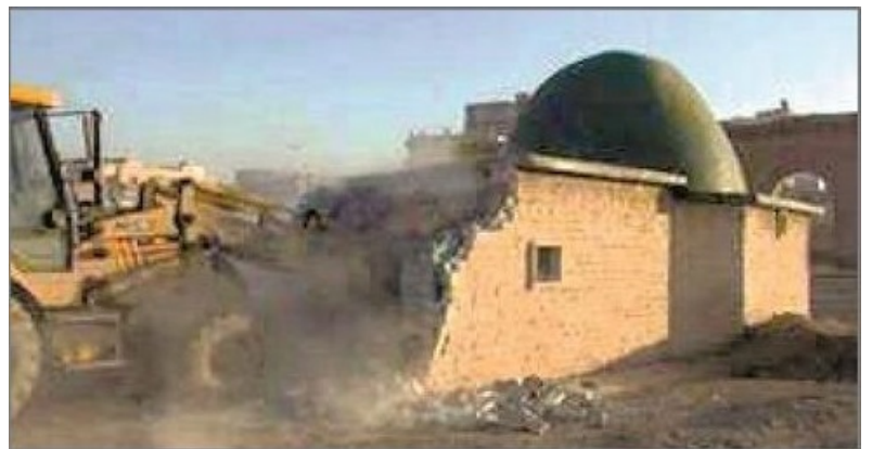
زیارتگاه وابصه بن معبد در حال تخریب با بولدوزر
