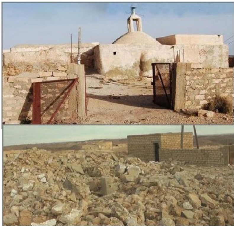
زیارتگاه ابوحاتم ملزوزی پیش و پس از تخریب
