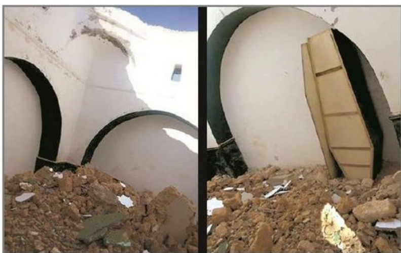
زیارتگاه سیدی بوسیف در طرابلس پس از تخریب
