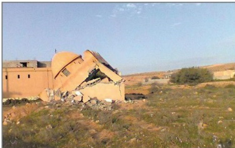
زیارتگاه عبدالقادر بن جدوع در زلین پس از تخریب
