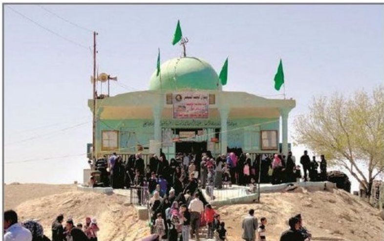
زیارتگاه بازسازی شده حاج یوسف در مندلی پس از تخریب آن
