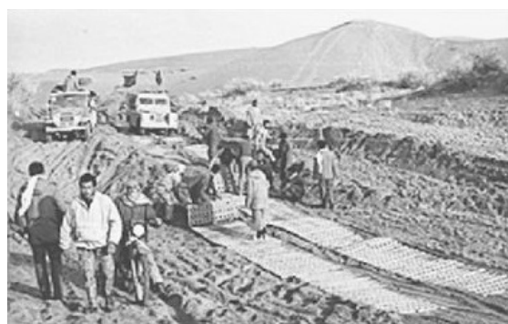
آماده سازی ساحل باتلاقی اروندرود برای عبور تجهیزات سنگین با استفاده از سطحه های پل خیبری، فرش باتلاق و...
