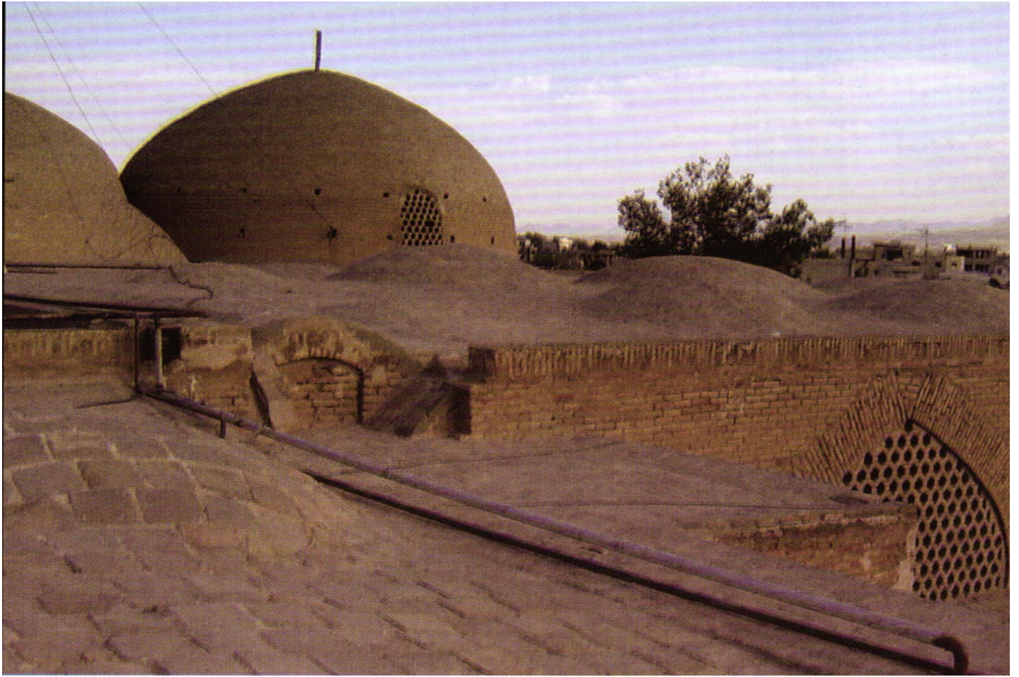
آجر کاری سقف ایوان و پله های دسترسی به ساعت
