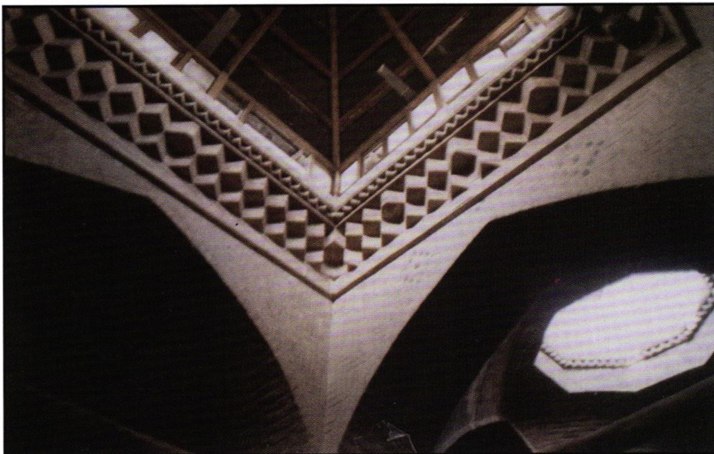
روشنایی و کلاه فرنگی سقف حوضخانه
