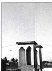
نمایی از آب انبار مسجد و مدرسه رکن الملک
